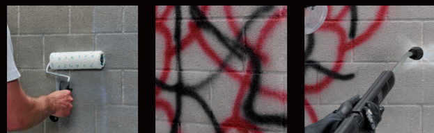
Nakładanie Zolpan 420 + Protection SG
